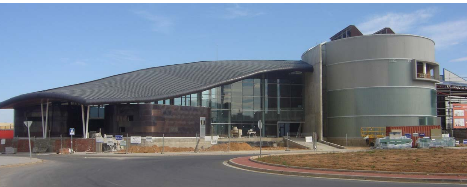
Centro Tecma, Alzira. Giner & Bono, Cullera. Cubierta de junta alzada
